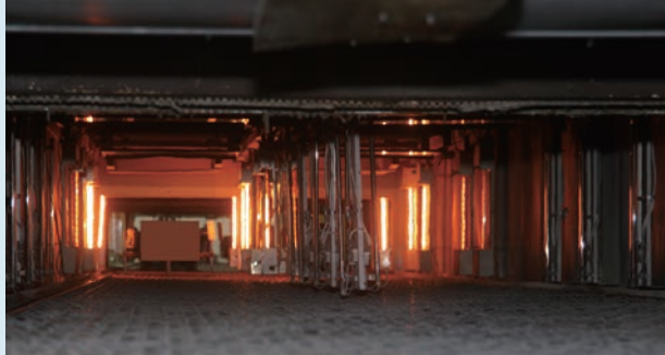
▲出口側から見た炉内(近赤外線点灯中)
